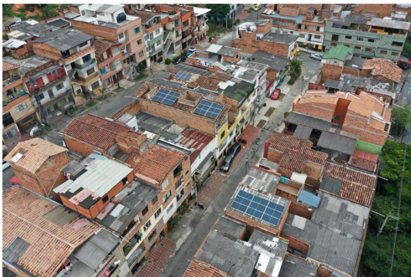
Foto cortesía de EPM Calle La Estrecha, barrio El Salvador, Comuna 9, Medellín.
