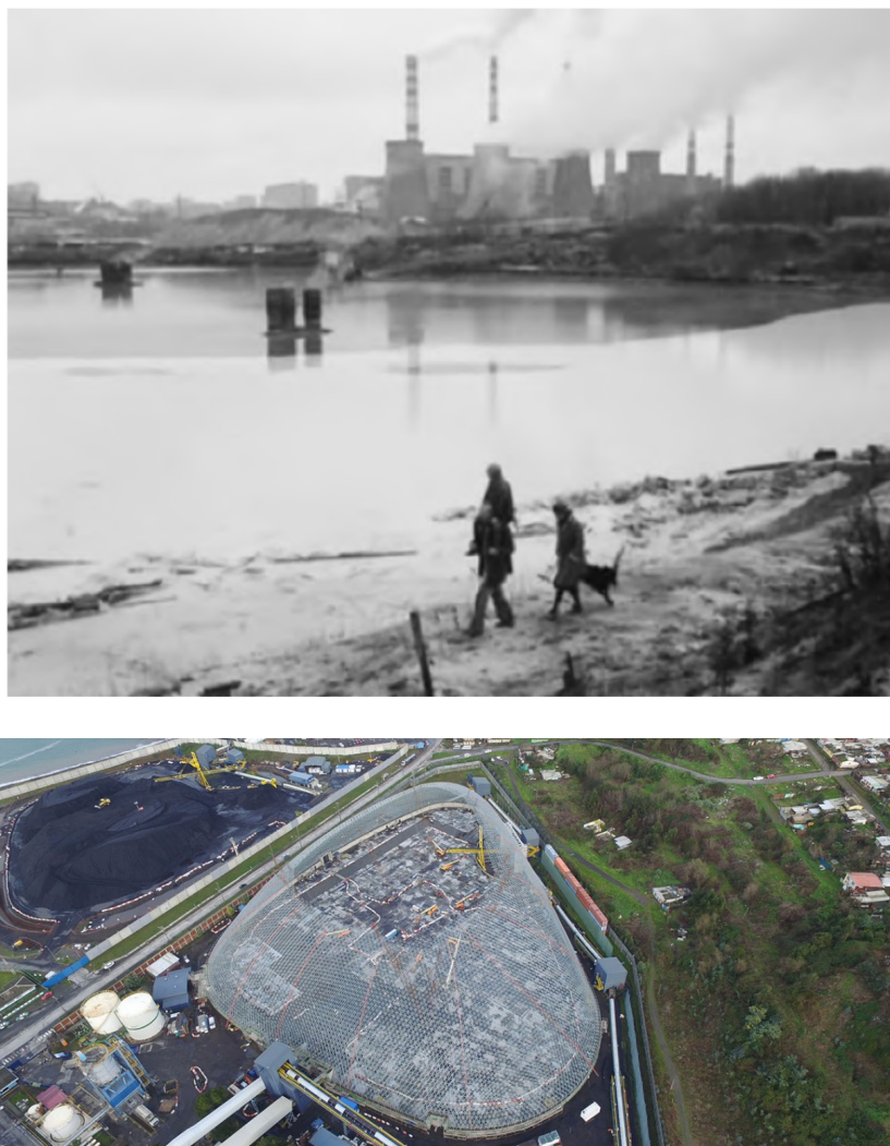
Figura 3. Central Bocamina 1 en 1979 e imagen aérea de domos en Coronel 2016
